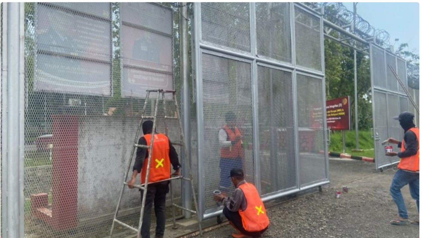
Pengecatan bangunan dan pagar Lapas Pasir Putih dalam rangka sambut HBO ke-59
