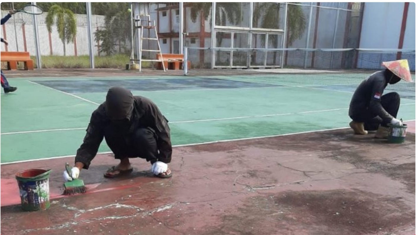
Lapas Pasir Putih Gelar Kegiatan Perawatan Gedung dan Bangunan Lapas
